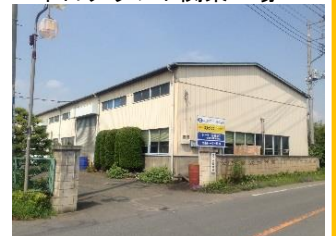
中日クラフト関東工場
